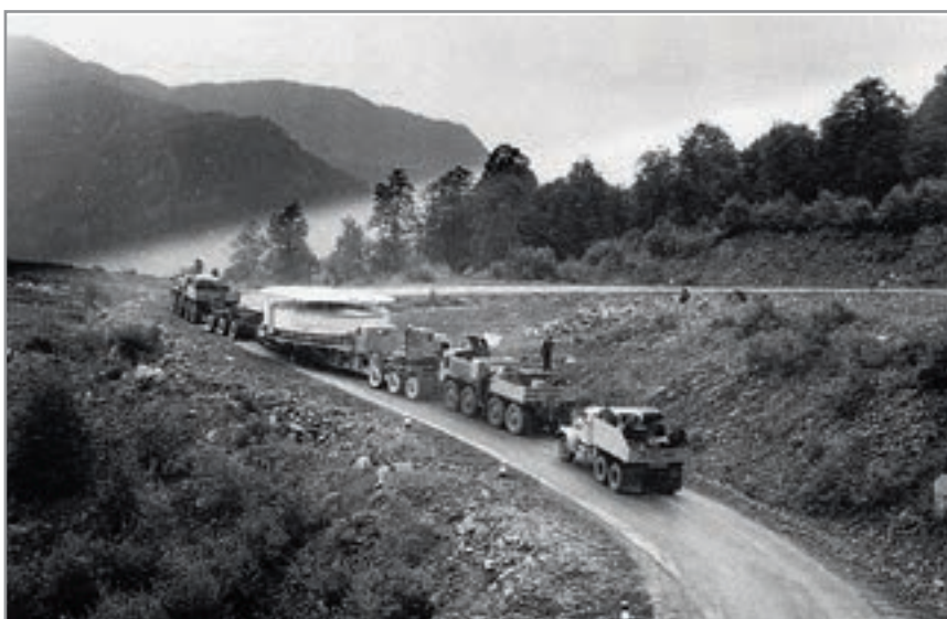
Рис. 158. Трейлер с главным зеркалом БТА на крутом повороте горной дороги к башне.
