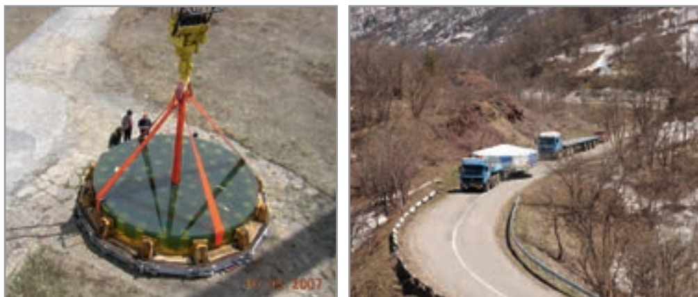
Рис. 5. Погрузка и транспортировка первого главного зеркала 6-м телескопа БТА, на котором проводились наблюдения в 1975–1979 гг., для переполіровки в ЛЗОС.
