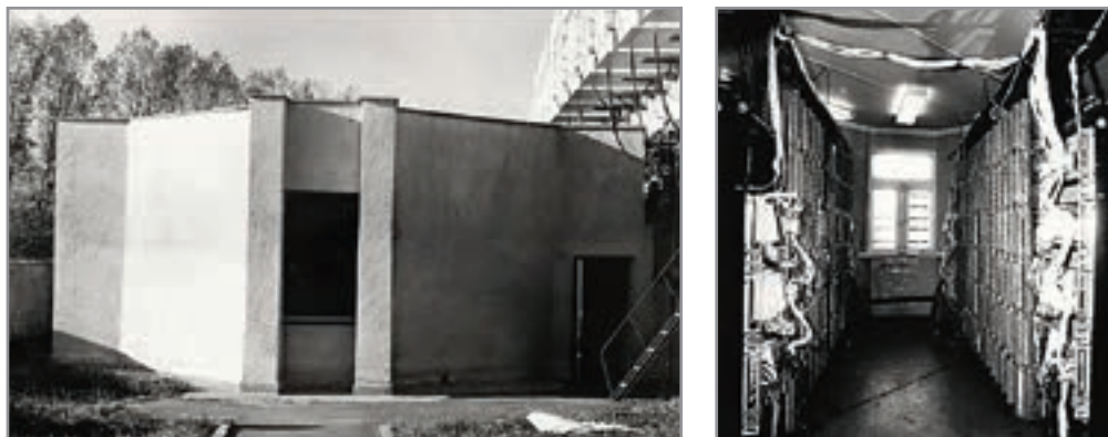
Рис. 41. Узел управления 100 элементами кругового отражателя – наружный и внутренний вид.
