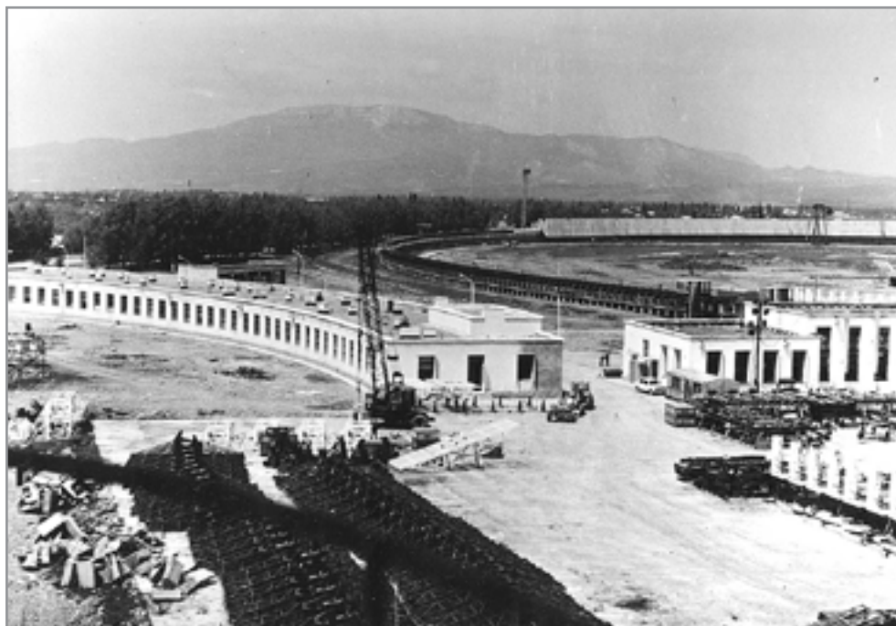
Рис. 133. Общий вид строительства РАТАН-600. Внизу слева лежат неокрашенные фермы отражательных элементов антенны. Окраска производилась здесь же.
