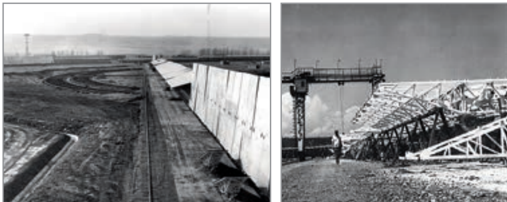
Рис. 134. Сборка плоского отражателя РАТАН-600.
