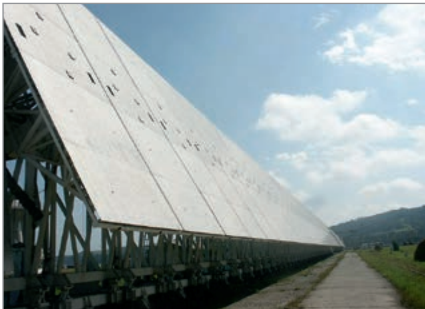
Рис. 142. Плоский отражатель РАТАН-600, используемый в режиме солнечных наблюдений. Он состоит из 124 отражательных элементов, каждый высотой 8.5 м и шириной 3.1 м. Его длина равна 400 м. Его наклон к горизонту можно менять от 0^\circ до 55^\circ , то есть возможны наблюдения источников со склонениями от -40^\circ до +55^\circ .
