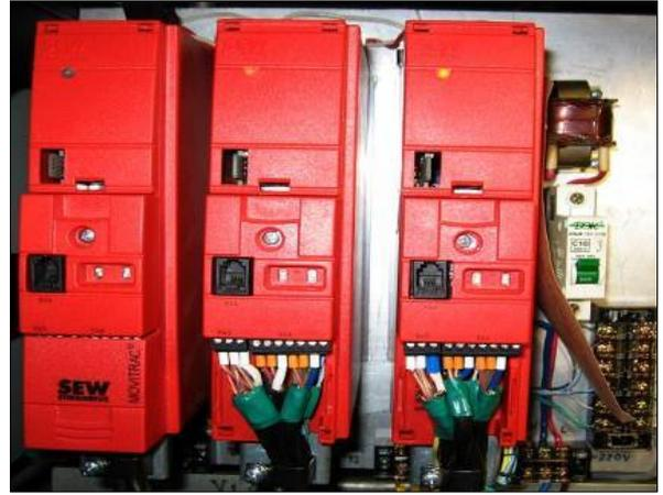
Рис. 14. Слева - щит частотных преобразователей для наведения и грубой коррекции, справа - частотные преобразователи для часового ведения и коррекции обеих осей телескопа.
