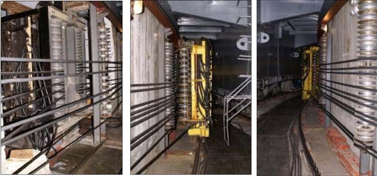
Рис. 9. Механизм выборки кабеля купола (в результате модернизации большая часть кабелей упразднена).
