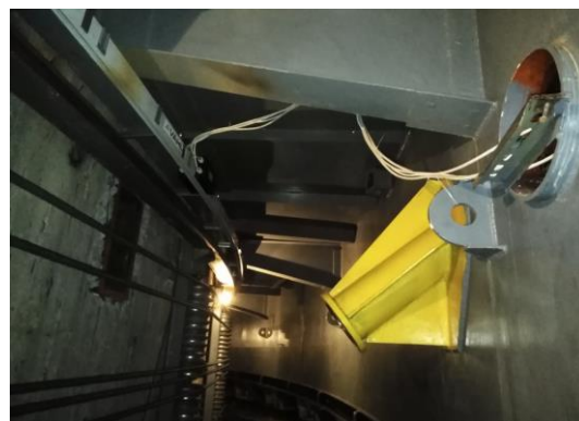
Разъемное водило купола (желтым)
