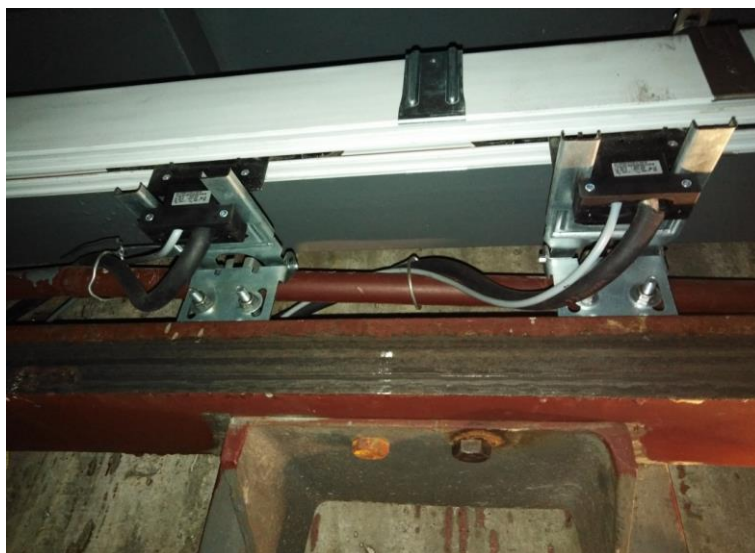
Двойной токоъемник (на суммарный ток 120 А)
